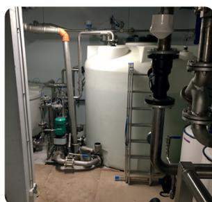
Le systeme de Neutralisation en Continu Actini (CNS) a ete specialement congu pour ajuster le pH des effluents issus de decontamineurs en continu.
